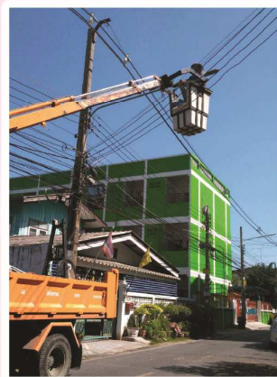
ซ่อมแซมไฟฟ้า ซอยคลองหลวง ๓๑ (ซอยรัตนะ) หมู่ ๗ คลองหนึ่ง
