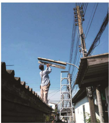
ซ่อมแซมไฟฟ้า ชุมชนเนรมิตร หมู่ ๓ คลองหนึ่ง
